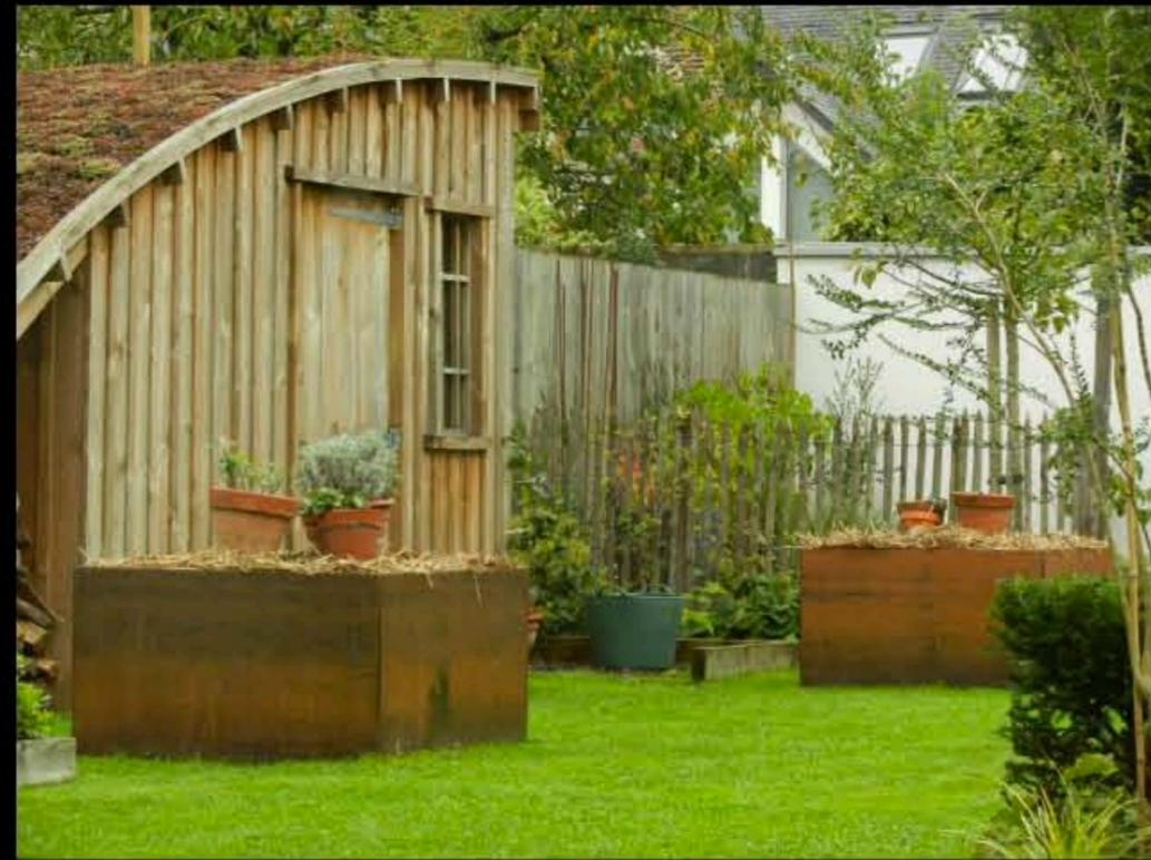
L'abri a été conçu en bardage de pin traité. L'intérieur dispose d'un plancher bois et la toiture, en prolongement d'un massif, a été végétalisée avec des sedums, des plantes succulentes qui ont la propriété de stocker l'eau dans leurs feuilles.
